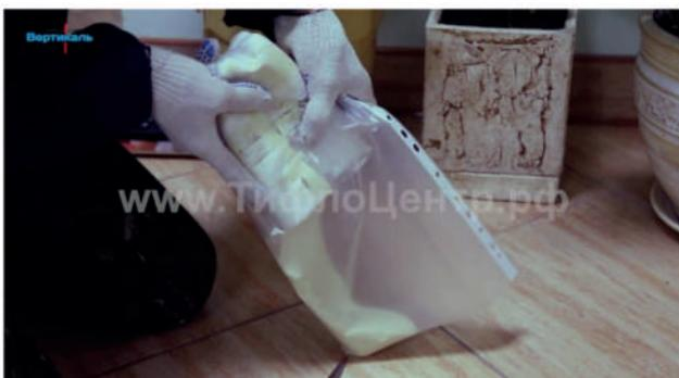
5. Подготовленную kleевую основу добавляем в обычный файл для документов и делаем из него кулёк. Отрезаем угол при помощи ножниц. Такой простой способ поможет нанести клей равномерно и быстро, не используя одноразовые инструменты.
