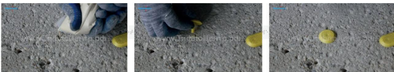
Фиксация на клей индикаторов со штифтами является трудоёмким процессом, так как данный вид монтажа требует сверления подстилающей поверхности. Но при точном соблюдении всех правил монтажа продукция прослужит долгое время без дополнительных мер обслуживания.
