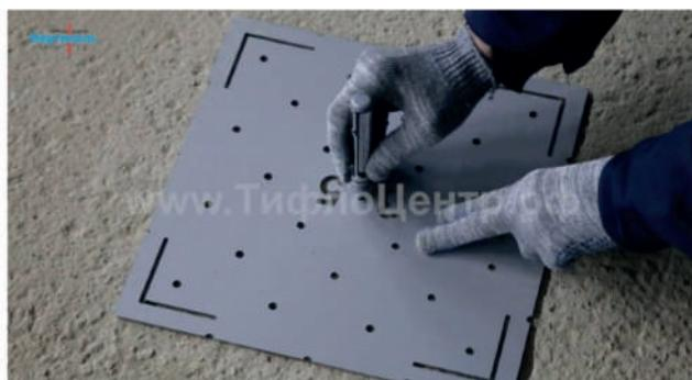
1. Размечаем рабочую область маркером в соответствии со схемой укладки (<https://tiflocentre.ru/taktilnye-indikatory.php>) тактильных указателей. Для этого используем трафарет. Как правильно выполнить разметку, вы можете посмотреть в разделе «Руководство по адаптации» (<https://tiflocentre.ru/voprosy-po-adaptacii-lokacii.php>) на нашем сайте. В зависимости от формы индикатора подбираем нужный шаблон. (<https://tiflocentre.ru/taktilnye-indikatory-trafarety-dlya-ustanovki.php>)
