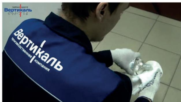
1. Очищаем поверхность от пыли и грязи при помощи растворителя и протираем спиртом. Это нужно для того, чтобы удалить тонкую пленку, оставшуюся от обезжиривателя и повысить адгезионные качества.
