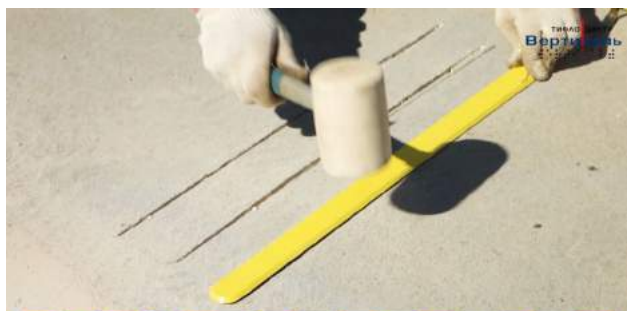
ЭТАП #5 Монтируем индикатор, прижимаем грузом
