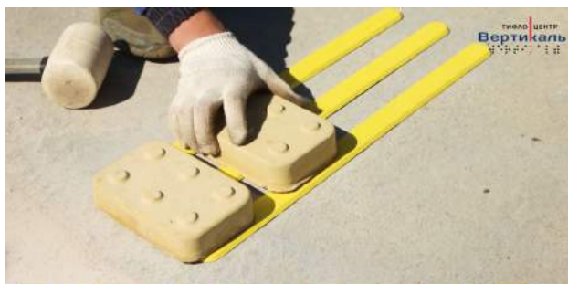
ЭТАП #5 Монтируем индикатор, прижимаем грузом
