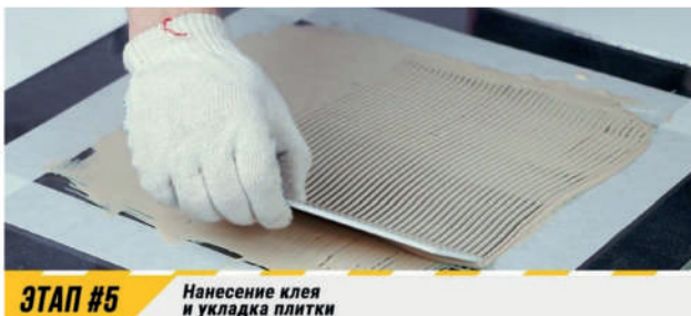
ЭТАП #5 Нанесение клея и укладка плитки
