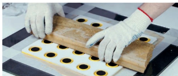
ЭТАП #6 Фиксируем смонтированную плитку
