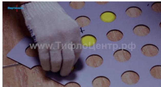
Монтаж тактильно-визуальной разметки в виде индикаторов закончен. Тактильные индикаторы будут готовы к эксплуатации через 5 часов. Полное высыхание клея произойдёт не ранее, чем через 24 часа после монтажа.
