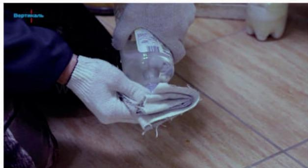
1. Очищаем поверхность от пыли и грязи при помощи растворителя и протираем спиртом. Это нужно для того, чтобы удалить тонкую пленку, оставшуюся от обезжиривателя, и повысить адгезионные качества.
